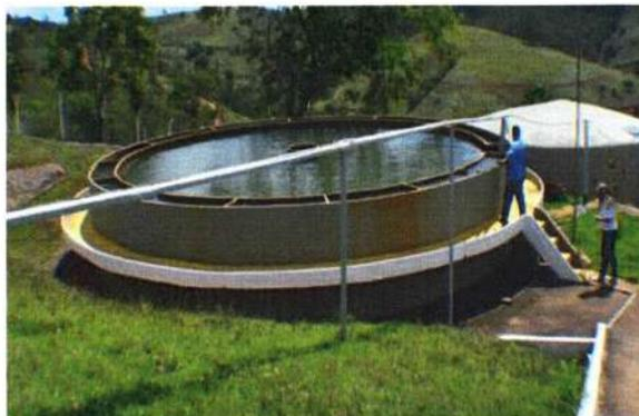
Figura 23: ETA – Decantador e floculador.
